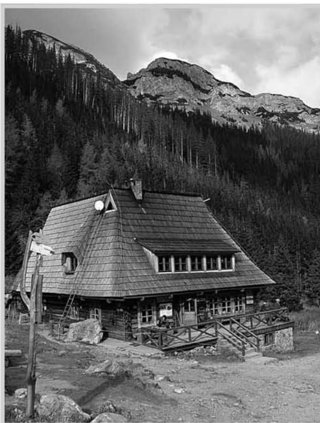
Schronisko górskie PTTK na Hali Kondratowej
