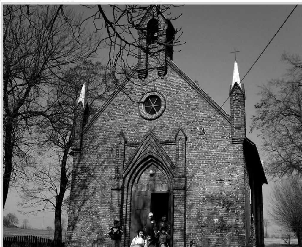
Kościół parafialny Kościoła Starokatolickiego Mariawitów pw. Przenajświętszego Sakramentu w Kadzidłowej, wybudowany w 1928 r.
