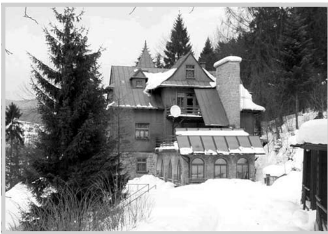
Bateria kolektorów słonecznych na schronisku Orlica w Szczawnicy w Pienińskim Parku Narodowym (źródło: www.orlica.com)
