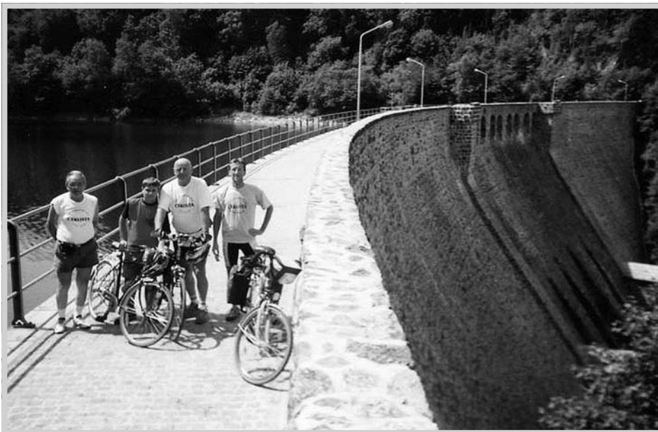
Na zaporce wodnej zbudowanej w latach 1911–1914 na Jeziorze Bystrzyckim – zabytek techniki
