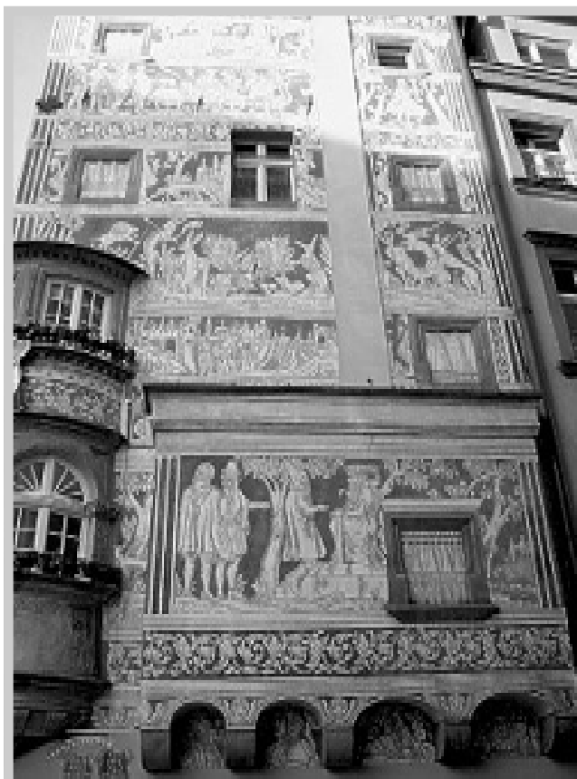
Kamienica Pod przepiórczym koszem w Legnicy
