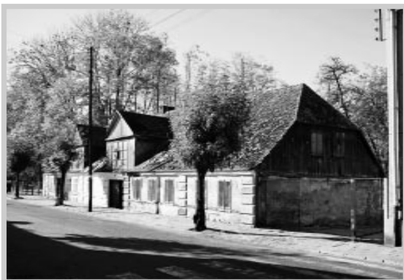
Stawiszyn, ulica Kaliska 16 – dom mieszkalny z I poł. XIX w., szachulcowy, kryty gontem, z dwoma wystawkami, służy lokatorom do dziś
