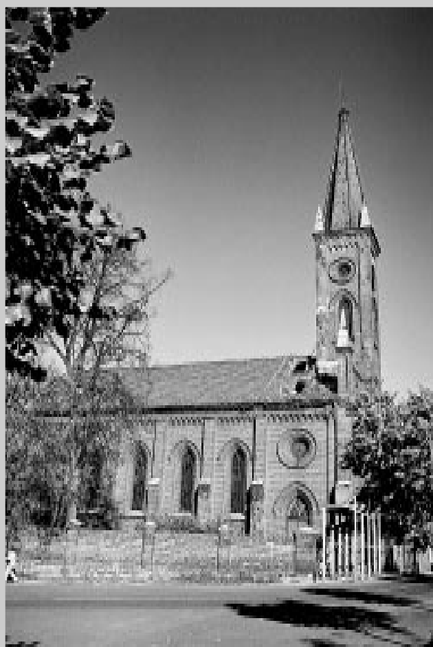
Opustoszały kościół ewangelicki w Stawiszynie, z dziurawym dachem i chylącą się wieżą
