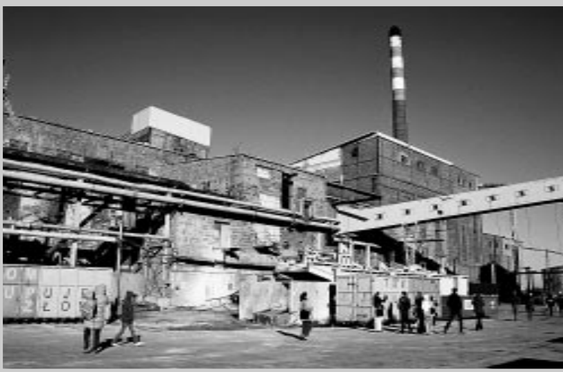
Wyposażenie cukrowni w Zbiersku, uruchomionej w 1852 r. przez Wilhelma Repphana, trafi po kawalku do kontenerów na złom
