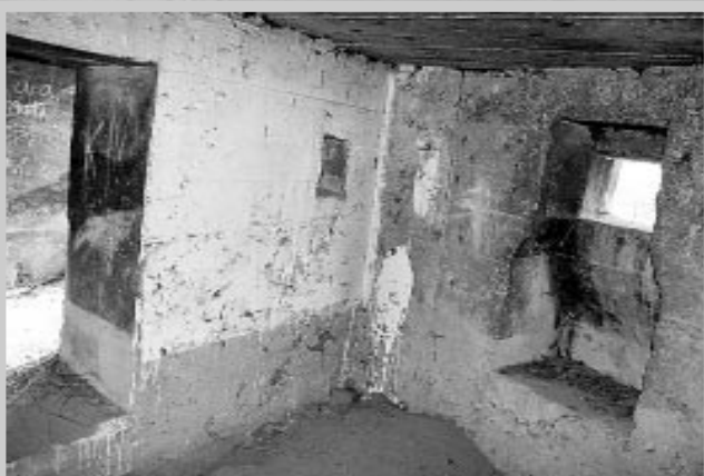
Wnętrze izby bojowej schronu do ognia bocznego dwustronnego (zob. foto powyżej). Z lewej widoczne wejście do schronu osłonięte przelotnią, z prawej nisza na przednie nogi podstawy ckm
