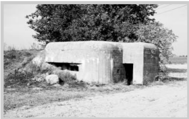
Schron bojowy do ognia bocznego dwustronnego znajdujący się na polu między Dobrzecem a Szczypiornem (wrzesień 2005 r.)
