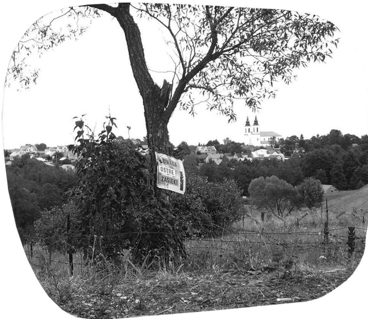
Widok na Bakalarzewo z otworu strzelniczego 52-tonowej kopuły pancерnej
