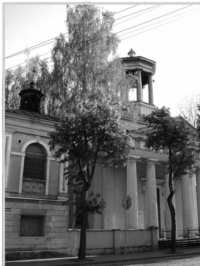
Fasada z monumentalnym sześciokolumnowym portykiem ze stiukowym Okiem Opatrzności w tympanonie dawnej świątyni ewangelickiej oraz murowana dzwonnica z drugiej połowy XIX w.
