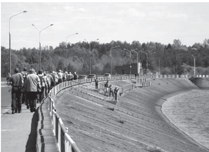
Zapora czołowa na Zalewie Sulejowskim ma około 1200 m długości, 16 m wysokości maksymalnej i 10 m szerokości w koronie
