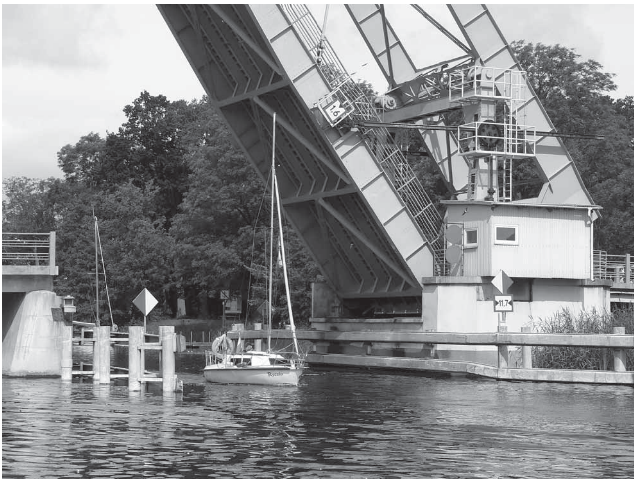
Rybina – drogowy most zwodzony na Szkarprawie, płynącej od Wisły do Zalewu Wiślanego
