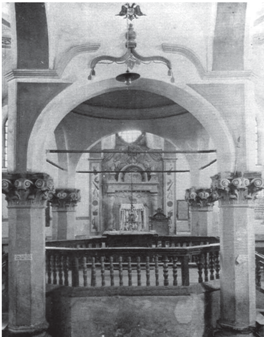
Wnętrze synagogi w Przysusze, w głębi szafa ołtarzowa. Zdjęcie z okresu międzywojennego
