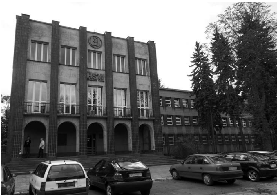
Główny budynek biurowy Huty „Stalowa Wola”
